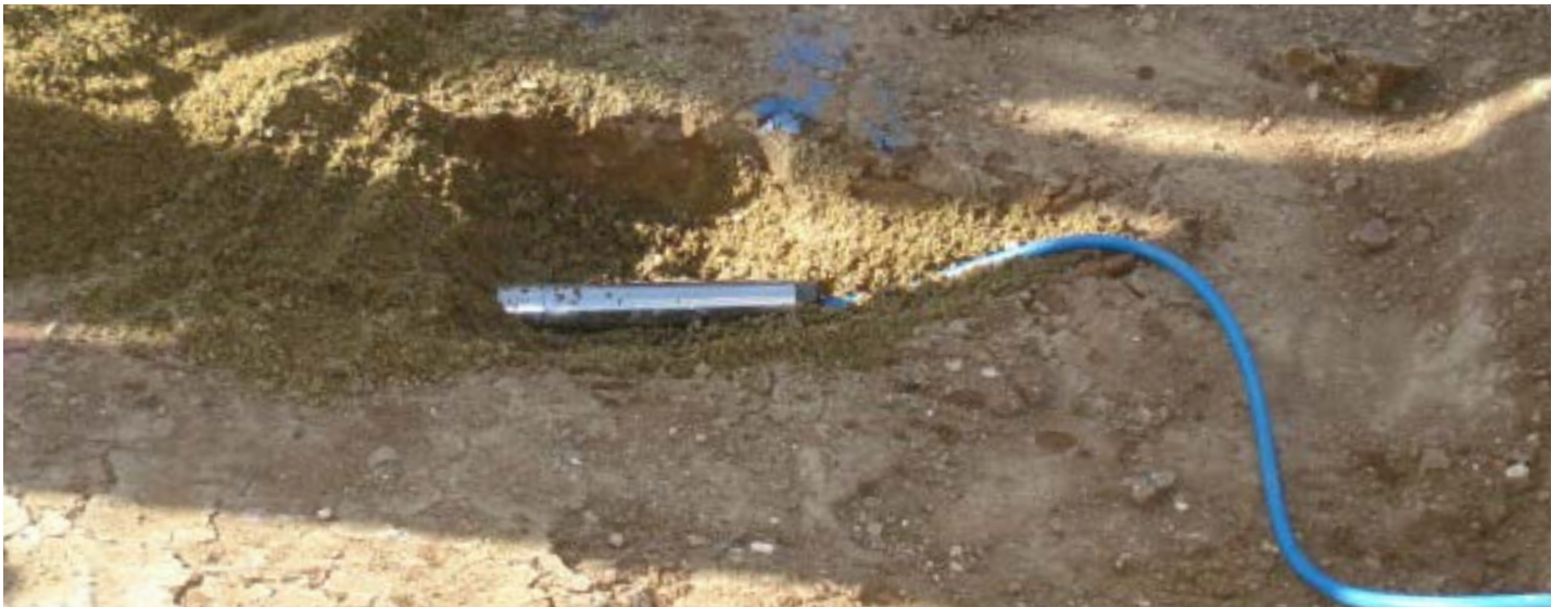
Piezómetro de cuerda vibrante en la fundación del terraplén de una presa
